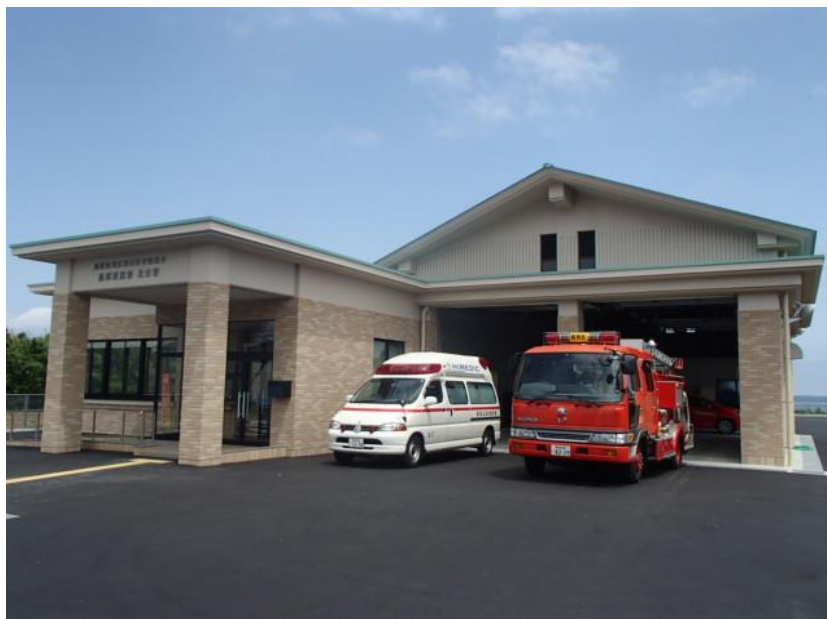
島原消防署北分署新庁舎 (平成 27 年 6 月 1 日運用開始)
