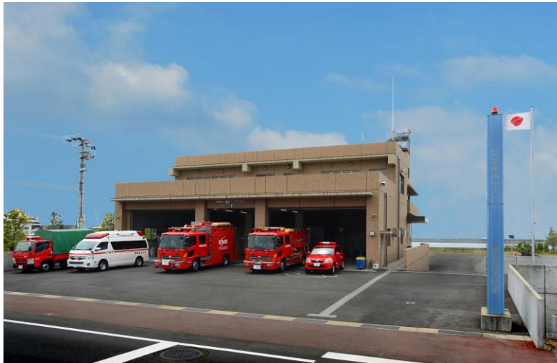
南島原消防署新庁舎 (平成 23 年 3 月 19 日運用開始)
