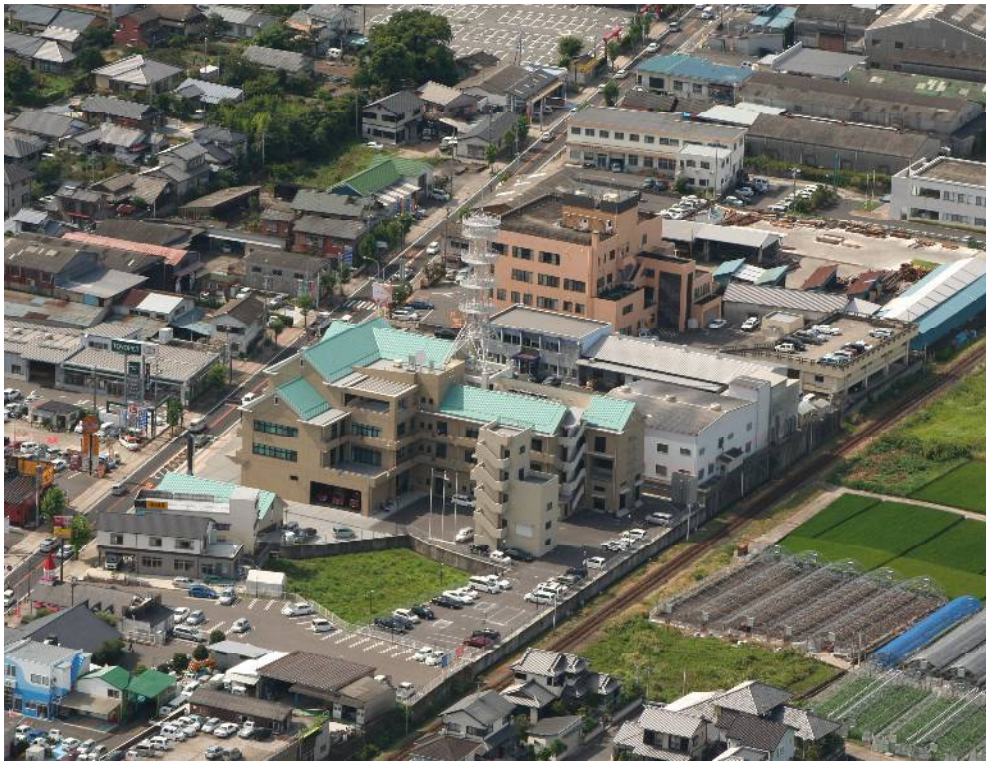
上空から見た消防本部庁舎
