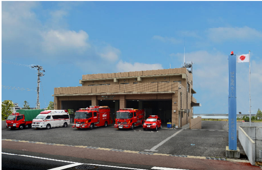
南島原消防署新庁舎 (平成 23 年 4 月 1 日運用開始)
