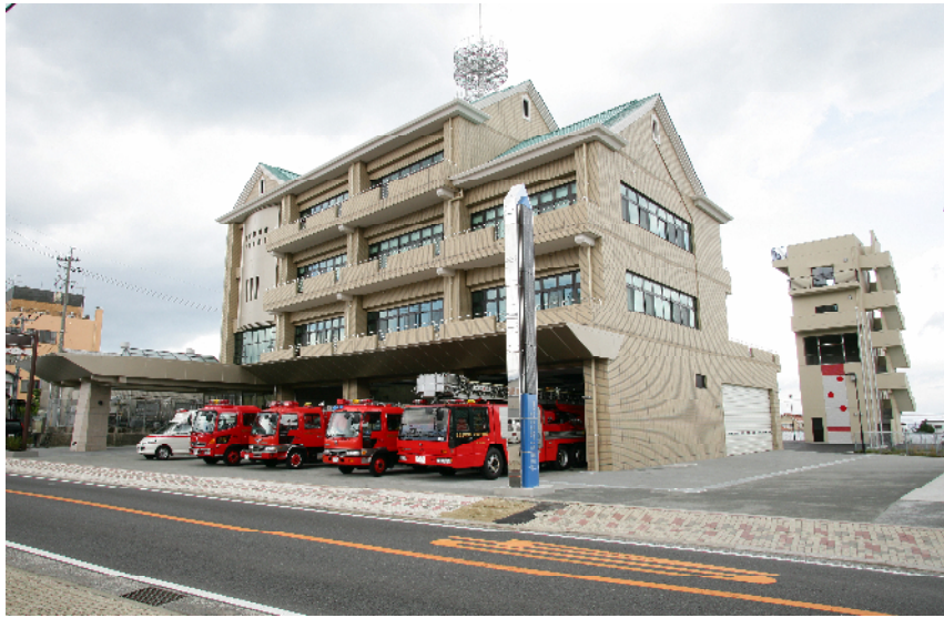
島原地域広域市町村圏組合消防本部・島原消防署新庁舎 (平成 18 年 5 月 10 日運用開始)
