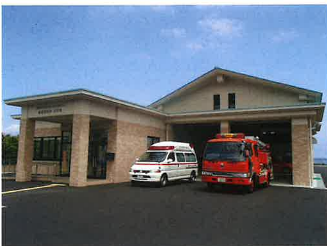
島原消防署北分署新庁舎 (平成 26 年 6 月 1 日運用開始)
