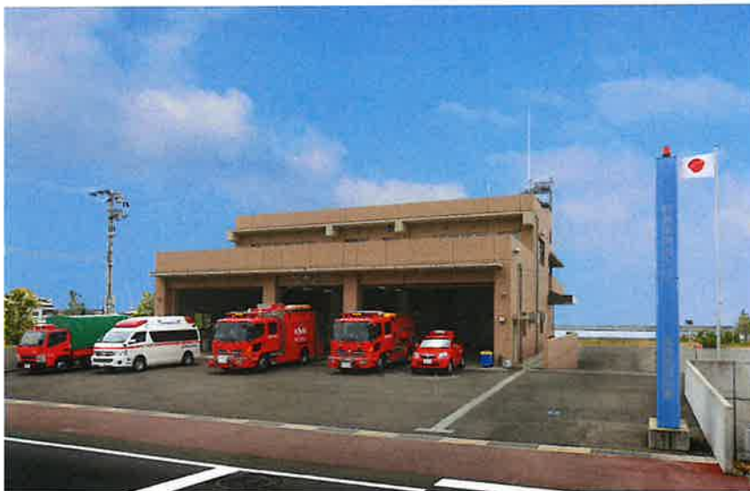
南島原消防署新庁舎 (平成 23 年 4 月 1 日運用開始)
