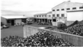
(株) 北衛生社 島原リサイクルプラント
