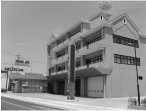
島原広域消防本部・島原消防署 (島原市新馬場町)
